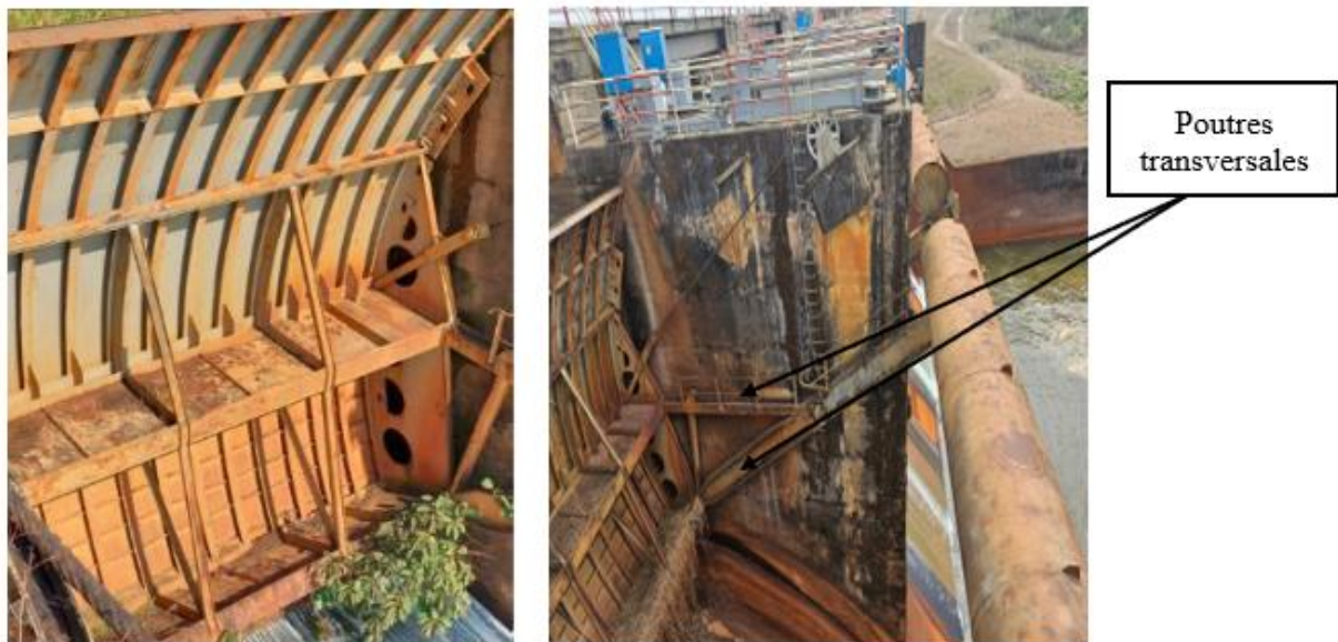
Figure 1: Vanne de surface avec ses poutres transversales
