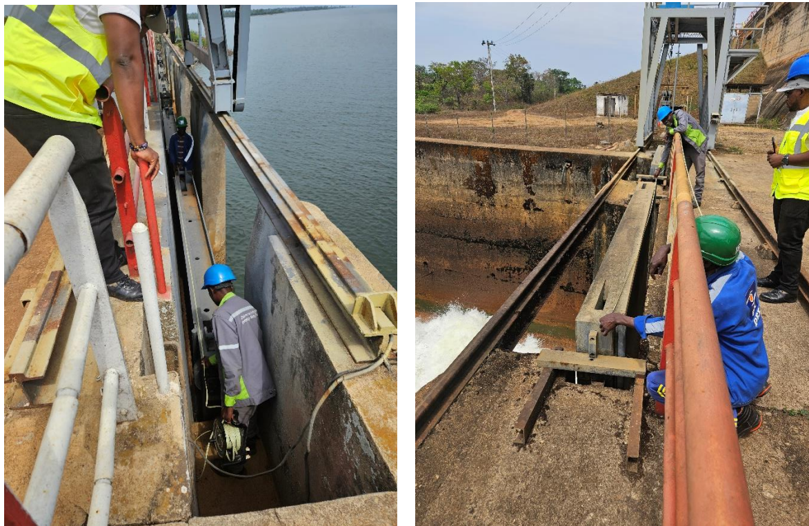
Figure 7: Batardeau amont (à gauche) et aval (à droite)
