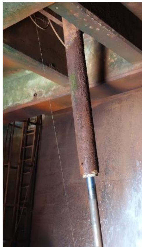
Figure 11: Vérins de la vanne de surface (à gauche) et de la vanne de fond (à droite)
