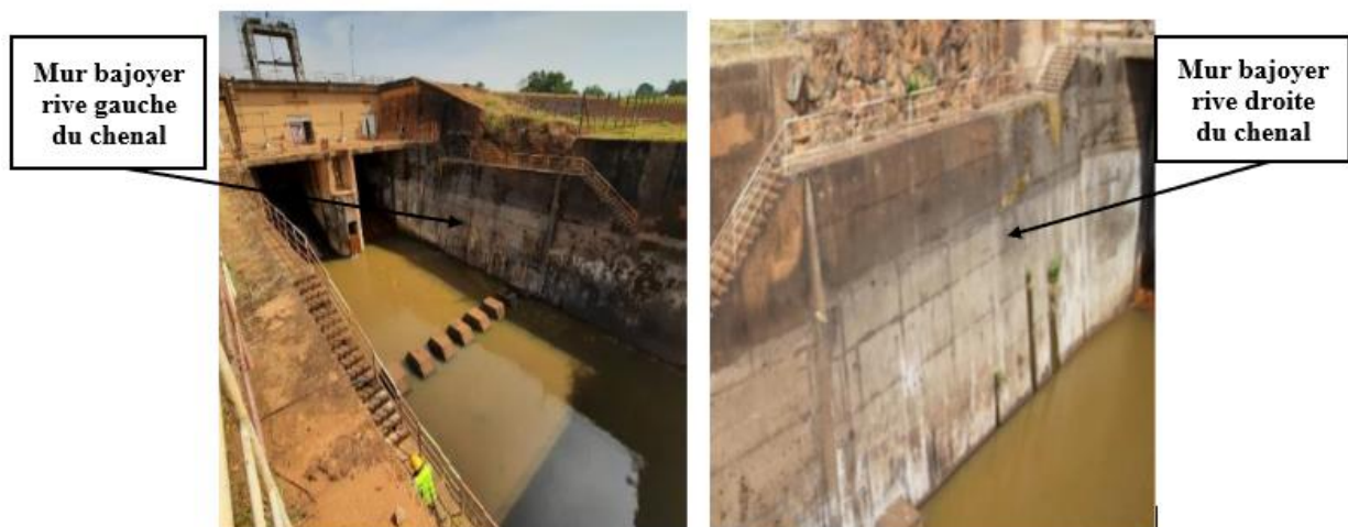
Figure 21: Murs Bajoyers au niveau du chenal de restitution
