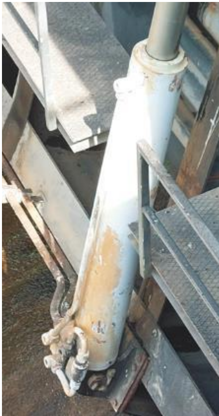
Figure 11: Vérins de la vanne de surface (à gauche) et de la vanne de fond (à droite)
