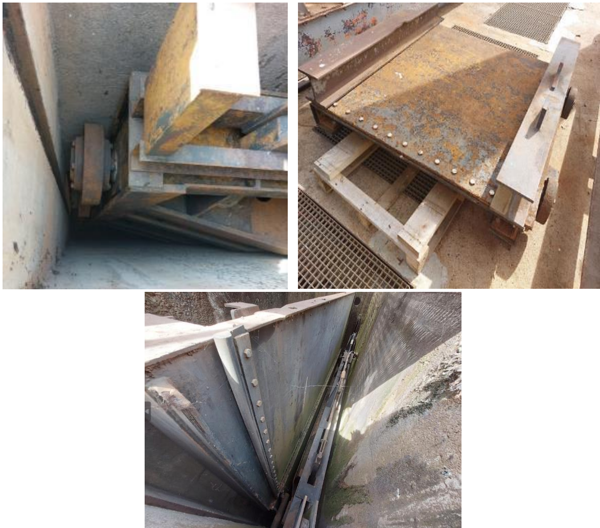
Figure 19: Éléments de batardeaux amont vanne segment, amont vanne wagon et aval vanne segment respectivement
