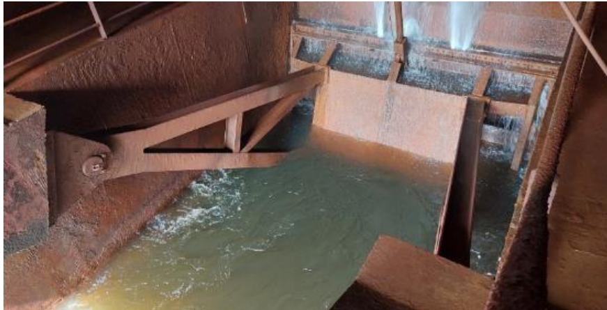
Figure 10: État vanne de fond
