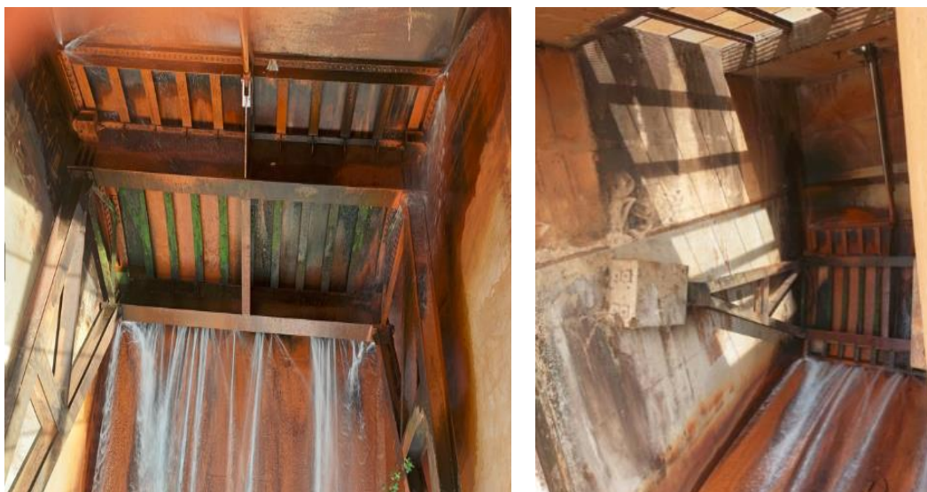
Figure 15: État des vannes segment
